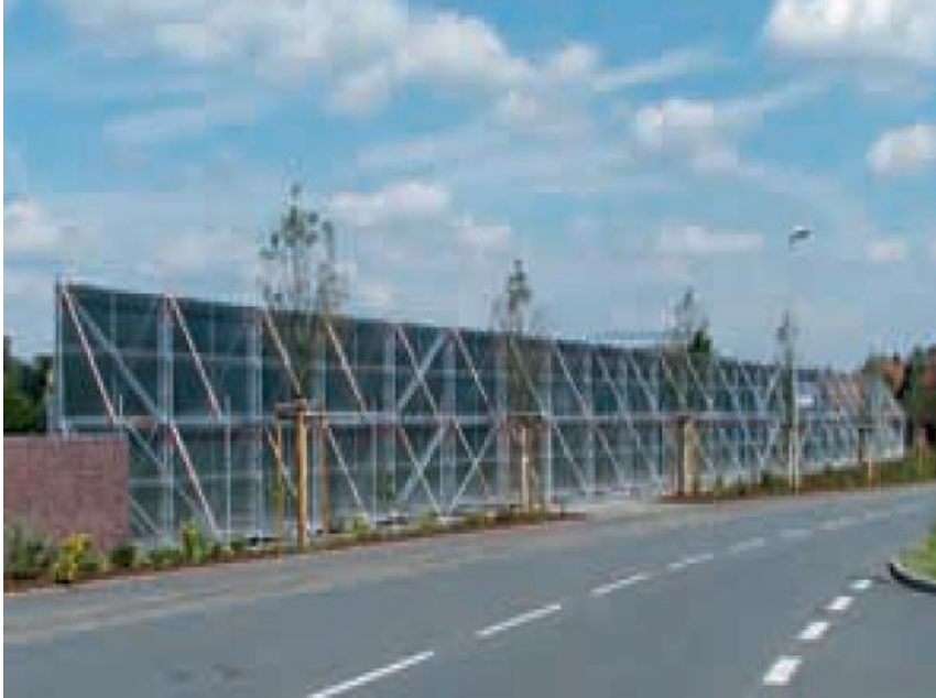
Ausführung als Schallschutzwand
