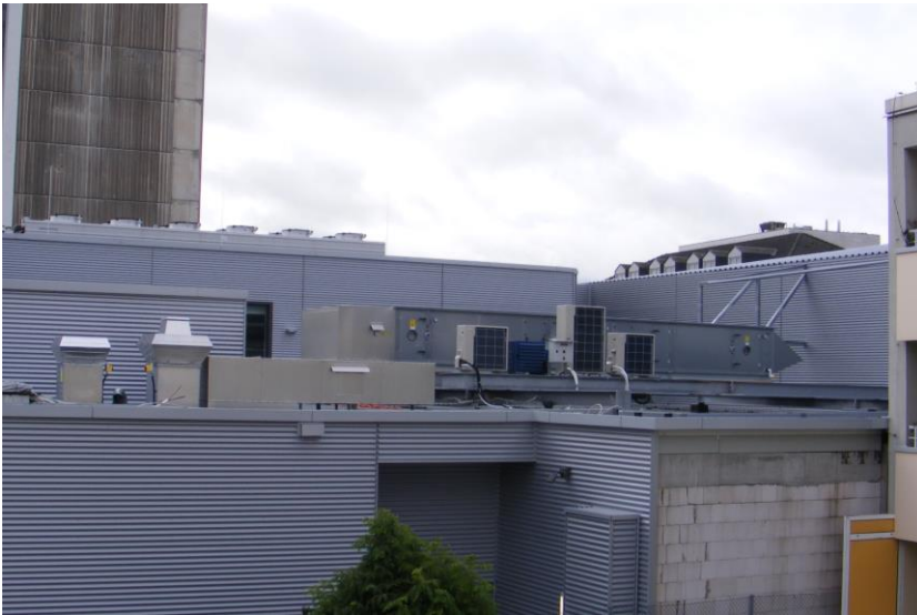
Ursprünglicher Zustand, Schallabstrahlung zu Wohnhaus
