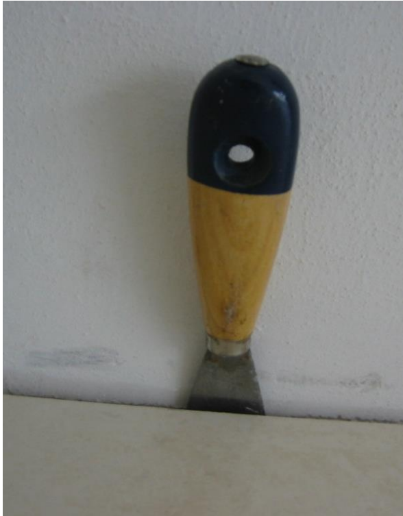
Überprüfung der Estrich - Randfuge mit Spachtel oder Kelle
