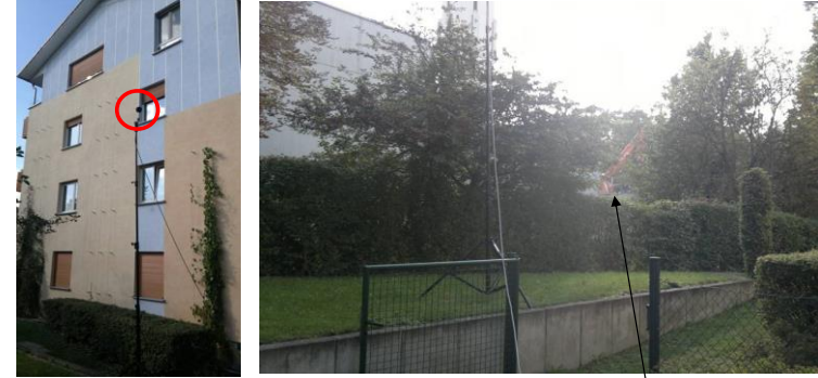
MP 4 an Gebäudekante (Südseite) und Blick von MP 4 auf die Baustelle
