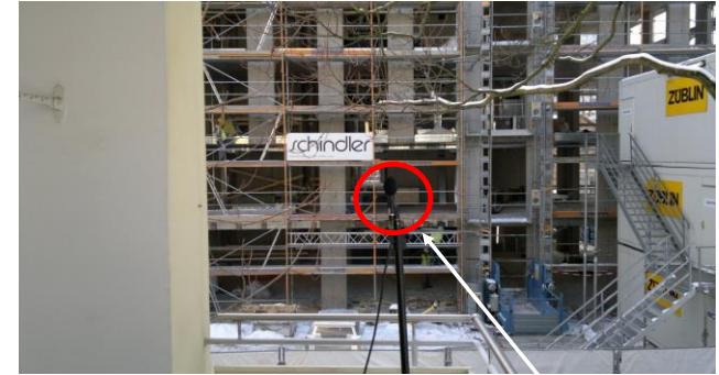
Blick von MP 3 auf Baustelle
