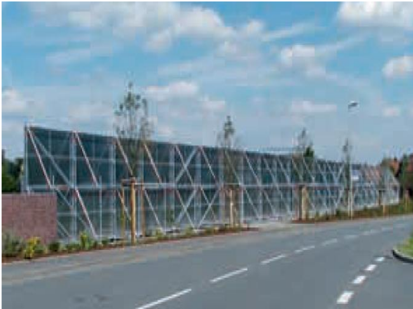
Ausführung als Schallschutzwand
