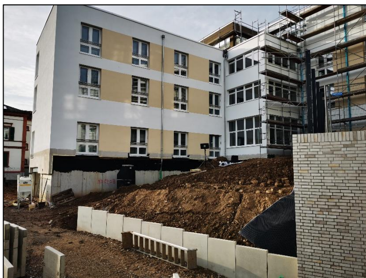
Abb. 3: Außenansicht während Fenstermessungen
